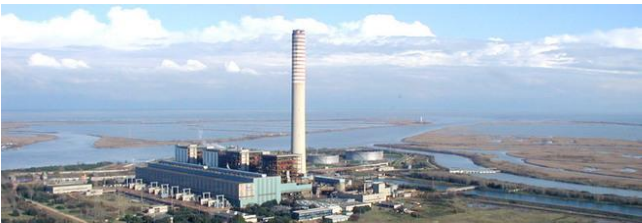
Vista della Centrale ENEL di Porto Tolle (Fonte: web)
